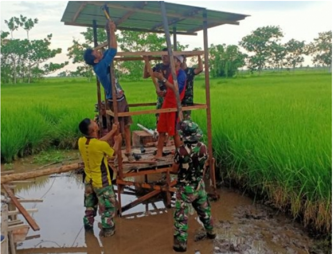
Pemasangan Atap WC
