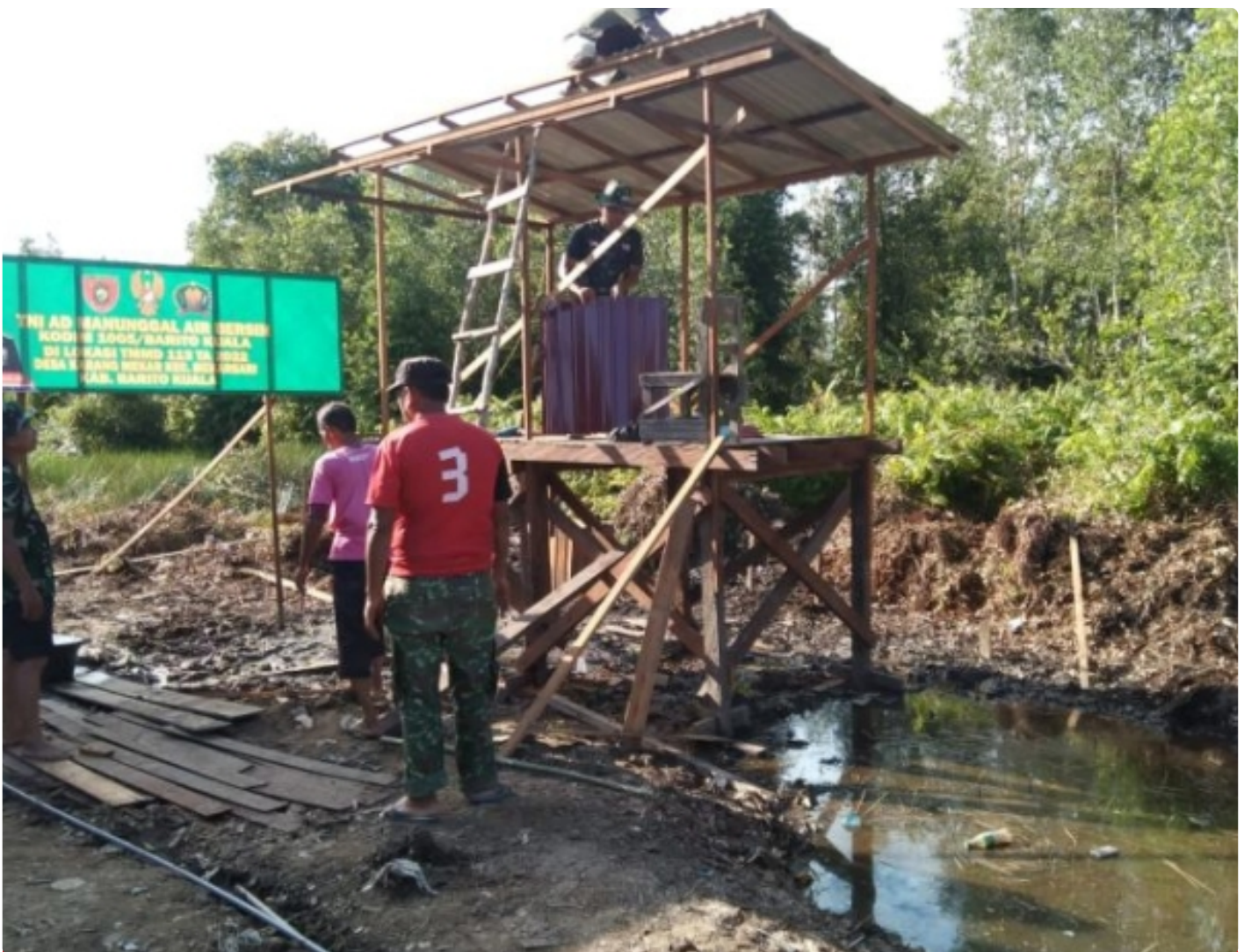
Anggota Satgas TMMD ke-113 Kodim 1005/Barito Kuala Pasang Atap WC
