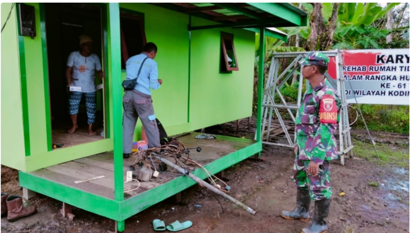
Melengkapi Renovasi RTLH Babinsa 1005-03/Rantau Badauh Monitoring Instalasi Listrik Dipasang
