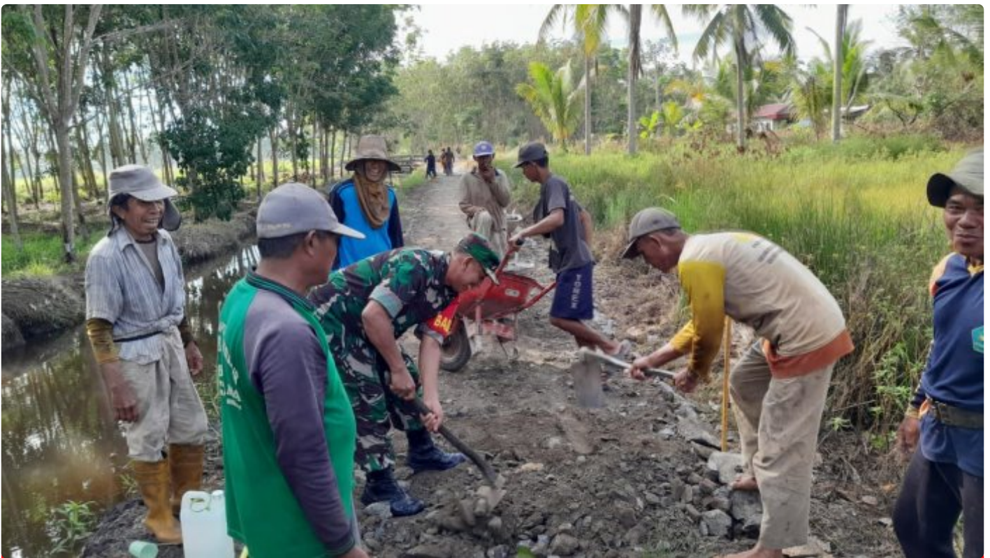
Bersama warga Binaan Babinsa Koramil 1005-10/Tamban Perbaiki Jalan Menuju Perkebunan
